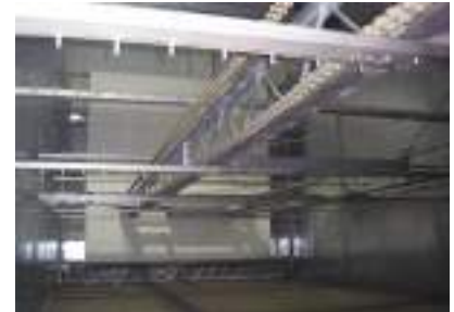
Deposito di stoccaggio per grandi quantità di ghiaccio con erosione superiore e sistema LIFO
